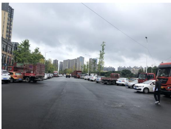
项目路面情况
